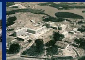
■ 工事中のキャンパス全景(1970年頃)
