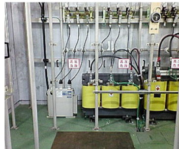
変電室内変圧器 鉄心改良型(アモルフラス)乾式変圧器
