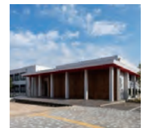
(2022 年度) 音楽棟改修
