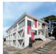
(2021 年度) 保健体育棟改修
