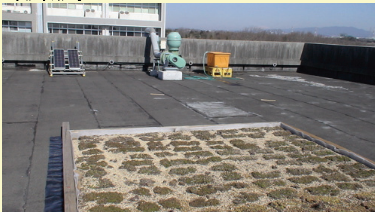
屋上緑化と太陽電池・雨水システム (美術・技術・家政棟屋上)
