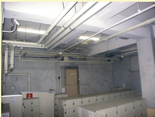
2005年度に撤去完了した吹き付けロックウール (アスベスト含有)
