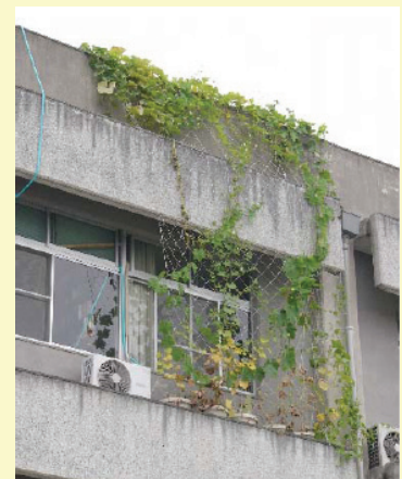
壁面緑化の状況
