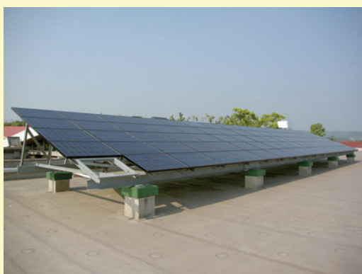
ソーラー発電システム設置状況 (附属岡崎小学校)
