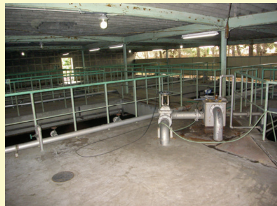
2006年度に撤去予定の吹き付けロックウール (アスベスト含有)
