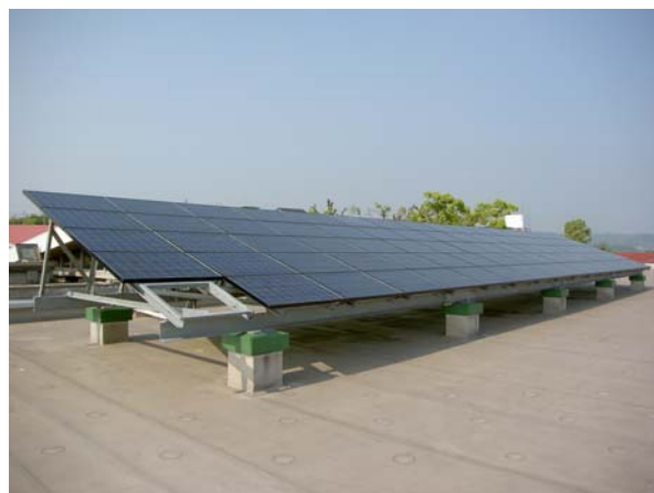
岡崎小学校ソーラー発電設備
