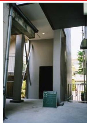
2006年度にバリアフリー対策で設置された第二共通棟のエレベーター
