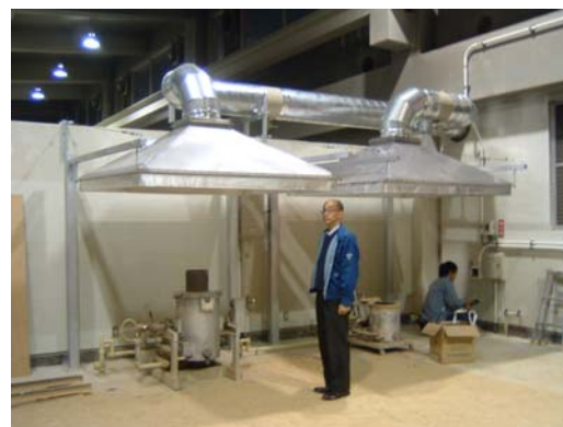
鑄金工房に局所排気装置を設置した後
