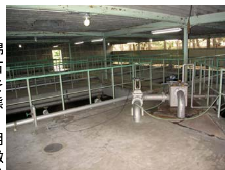
吹き付けアスベスト除去が完了した排水処理施設
