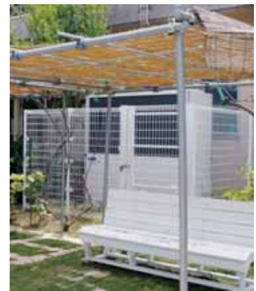
室外機の熱交換を効率よくするキウイ棚
