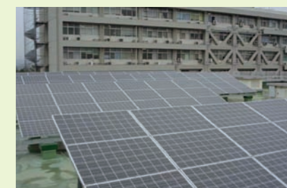
太陽光発電設備の設置
