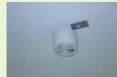
講義室に設置された空気攪拌ファン
