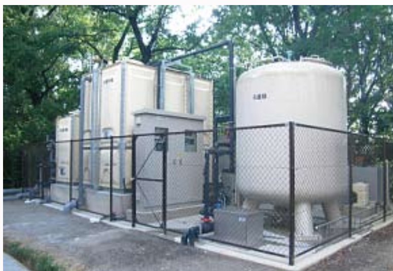
地下水浄化設備
