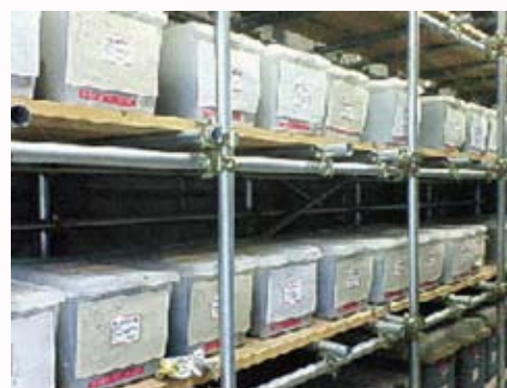
蛍光灯安定器保管状況（学生寮ボイラ室）
