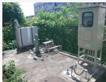
中和処理施設 (改修：平成 23 年度)
