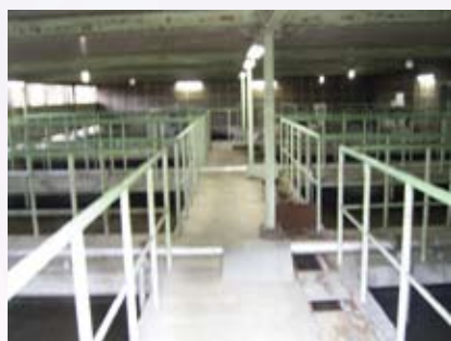
生活排水処理施設 (設置：昭和 50 年度)
