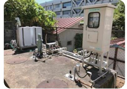
中和処理施設（pH常時監視）により実験系排水を管理
