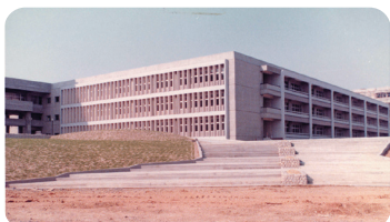
第一共通棟 (昭和45年頃)
