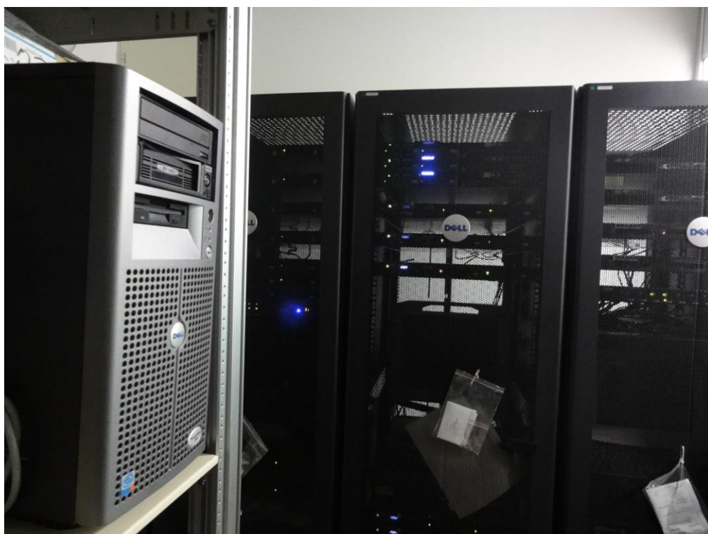
研究室にサーバー類が設置されている様子
