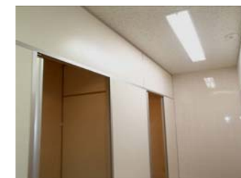
便所改修(ブースの立上げ)
