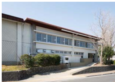
外部改修後(北面)
