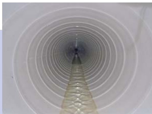
改修後（更正工法）
