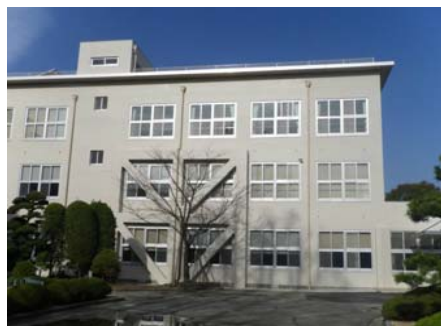
外部改修後 耐震補強 (鋼板内蔵RCブレース)
