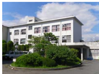
建物外観(改修前後)
