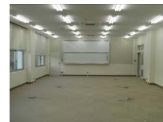
内部改修後 職員室
