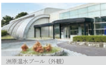
洲原温水プール(外観)
