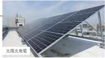
太陽光発電により、自然エネルギーを活用し CO<sub>2</sub>削減に貢献する。10KWの太陽光発電を設置。
