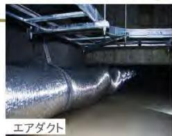
土中・地下ピットに設けたエアダクトによる熱負荷低減
