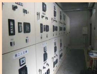
老朽化したライフライン設備（受変電設備、ガス管）
