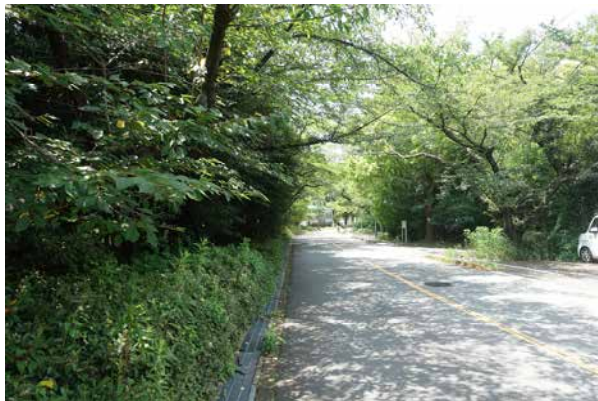
図 2-11 構内幹線道路にせり出した樹木
