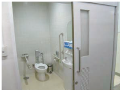
多目的トイレの設置(美・技・家棟)
