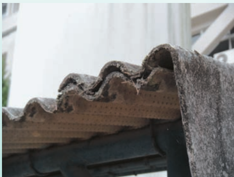
スレート屋根の撤去
