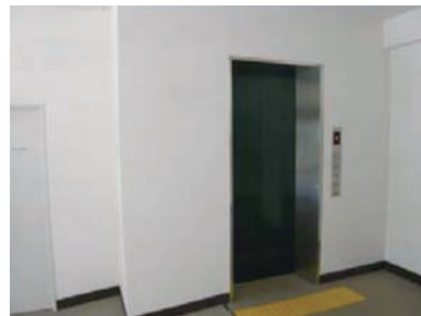
エレベータの設置(美・技・家棟)
