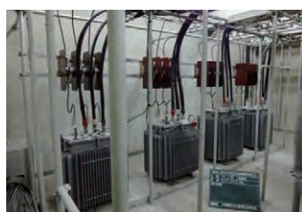
施工前 (H22.2) 自然科学棟変電室
