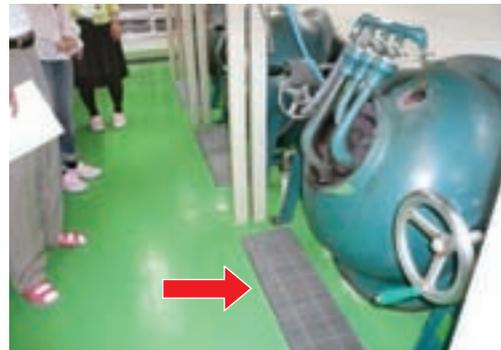
図2 改善例:回転釜下のピットにグリッド(矢印)を置き踏み外し防止
