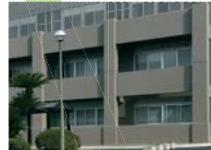
耐震補強 プレキャストコンクリートアウトフレーム工法庇効果による日射熱の侵入を低減し居住環境を改善
