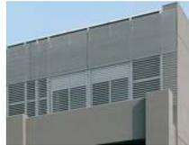
ルーバーによる日射熱の侵入の低減と複層ガラスによる断熱効果により省エネの実現
