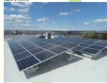
太陽光発電設備(出力12.5kW)
