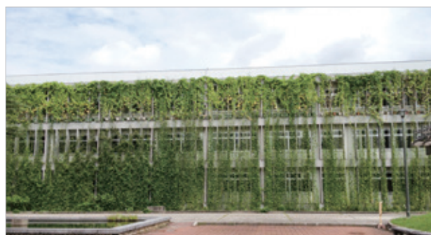
共通棟西側 2014 年 8 月 27 日
