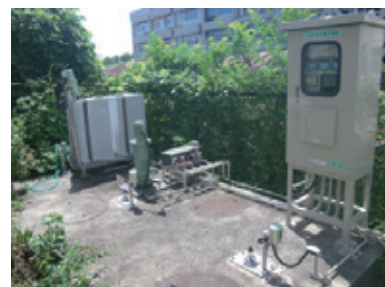
中和処理施設 (改修：平成 23 年度)
