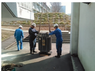
微量 PCB 汚染物 処分のための撤去作業(大学)
