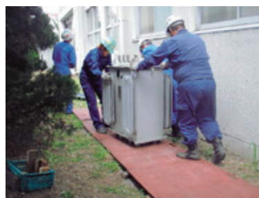
微量 PCB 汚染物 処分のための撤去作業 (附属名古屋中学校)
