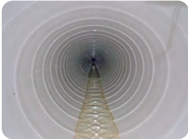
本学の排水管改修工事の一例（ライニング工法）
