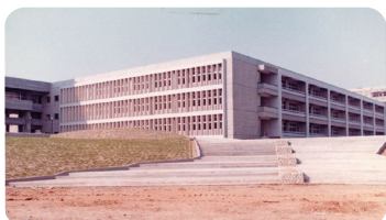
第一共通棟 (昭和45年頃)
