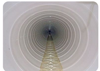
本学の排水管改修工事の一例
