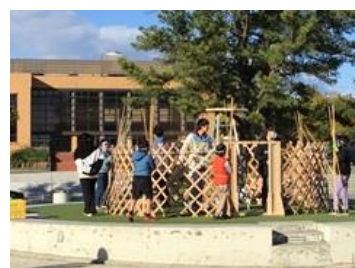
モンゴルの移動式住居「ゲル」 を組み立てる様子
